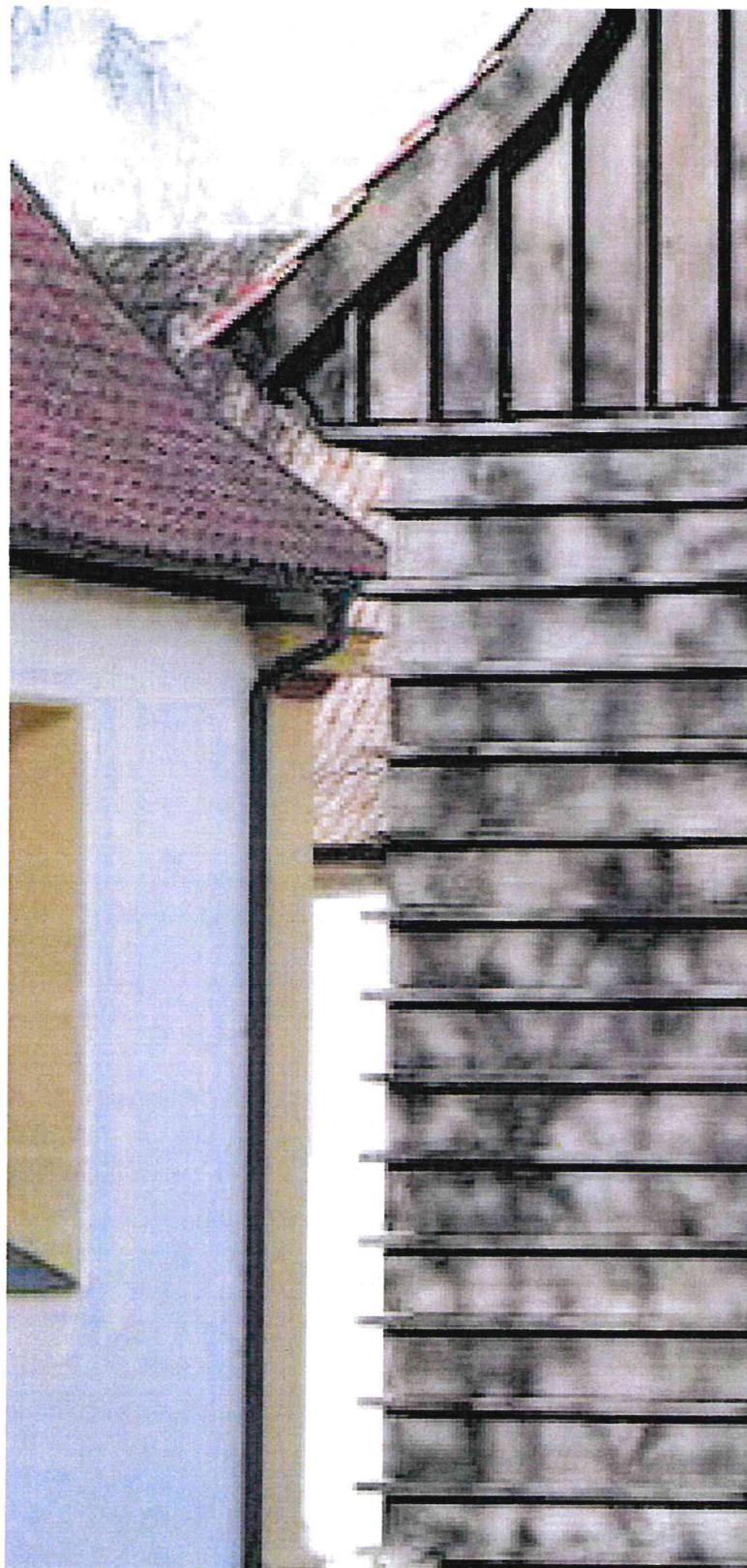
Gebäudetypologie | Satteldach mit Aufschiebling
