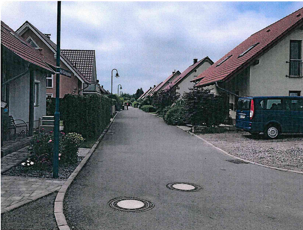
Straße Am Eselsgraben / Ecke Sandweg mit Kanaldeckel
