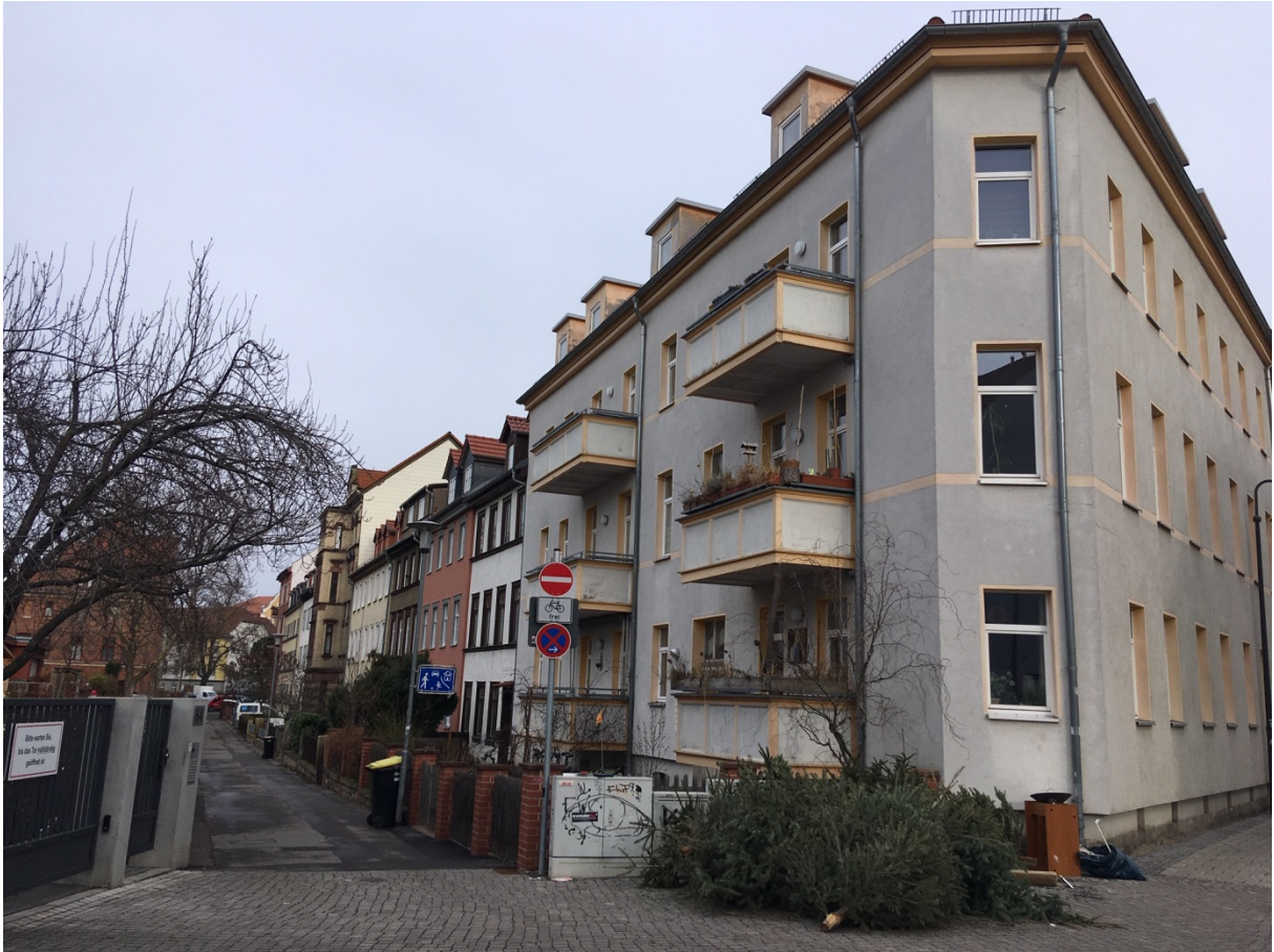
Blick in die Hopfengasse; Standpunkt Kartäuserstraße
