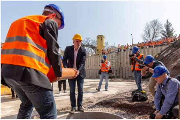
Abb. 20: Grundsteinlegung für das Überlaufbecken in der Karlsstraße 2018
