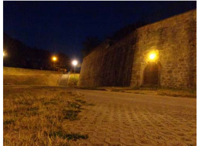
Abb. 9: Von außen werden die Schießscharten intensiv von der Wegebeleuchtung angestrahlt. (hier der Westflügel), die als Ein-/Ausflugöffnungen genutzt werden.
