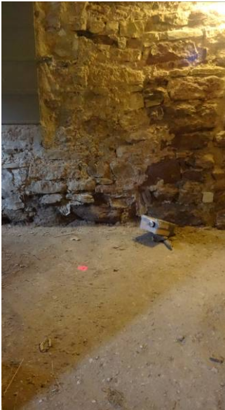
Abb. 2a: Installiertes Anabatgerät im Gang der Ravelin Anselm
