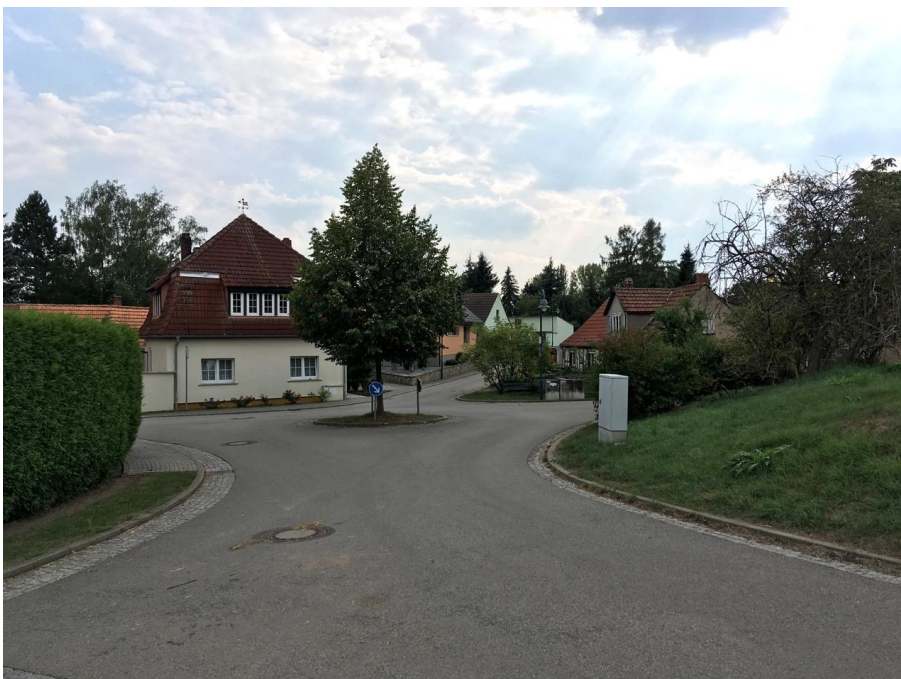
Kreuzung/ Einmündung Am Knotenberg / Im Brühl
