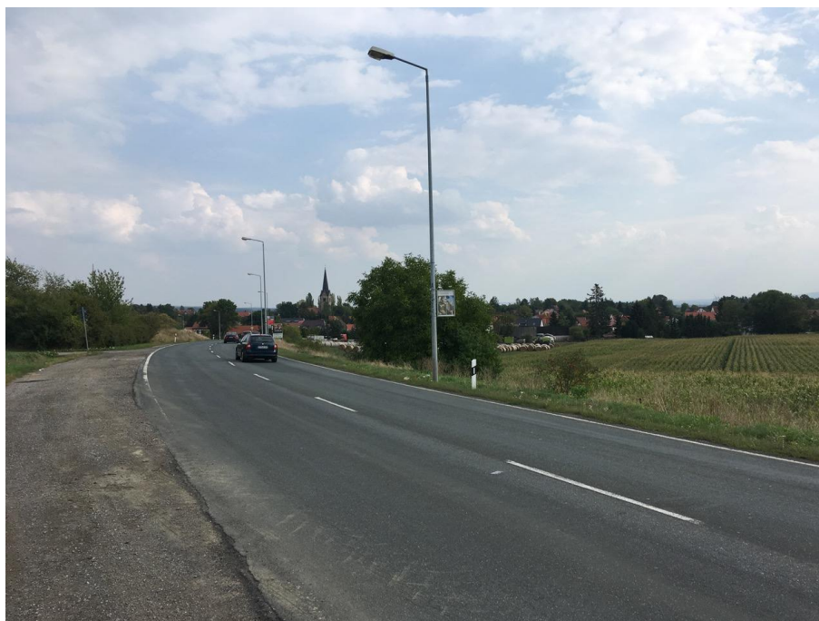
Eisenacher Straße im Bereich des Plangebietes
