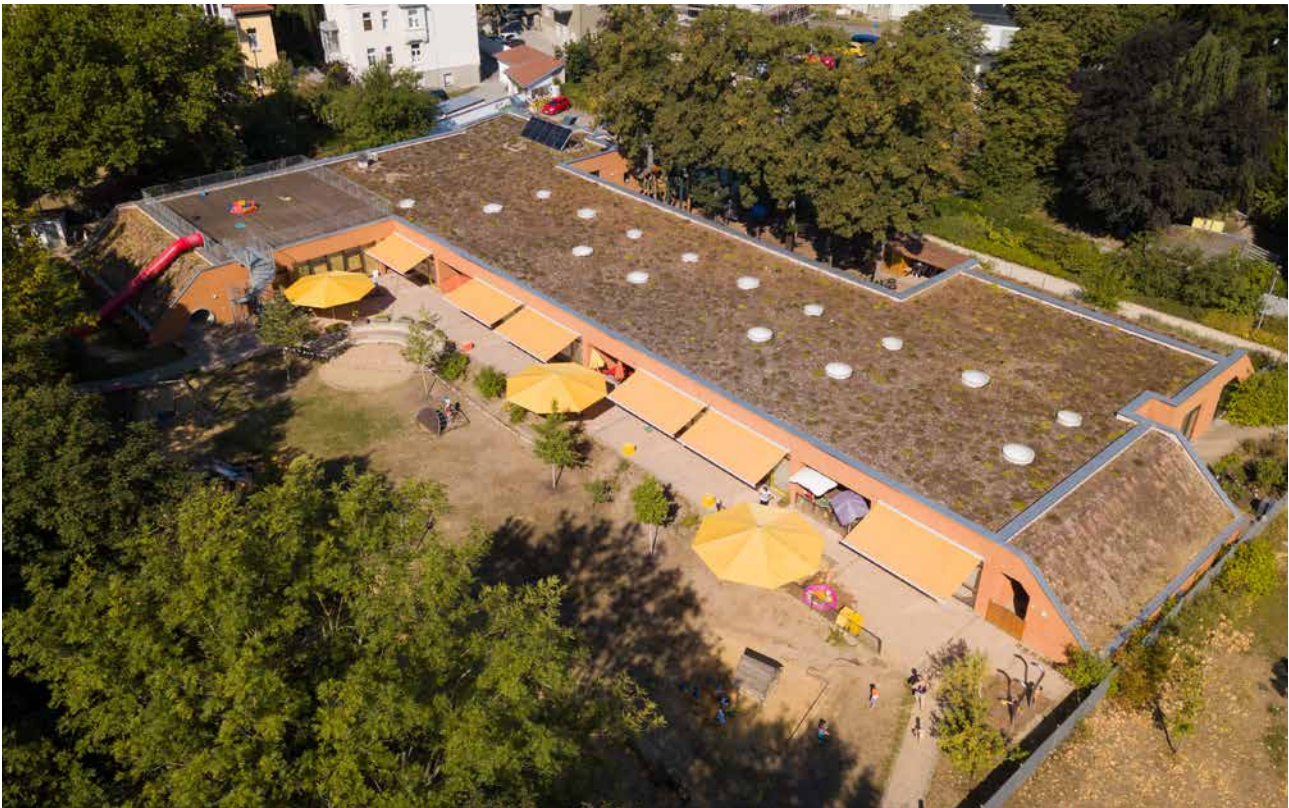
Abb. 22: Dachbegrünung und Verschattung am Gebäude der Kita „Rasselbande“
