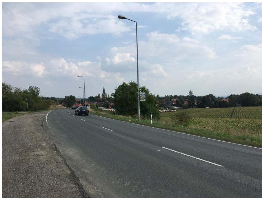
Eisenacher Straße im Bereich des Plangebietes
