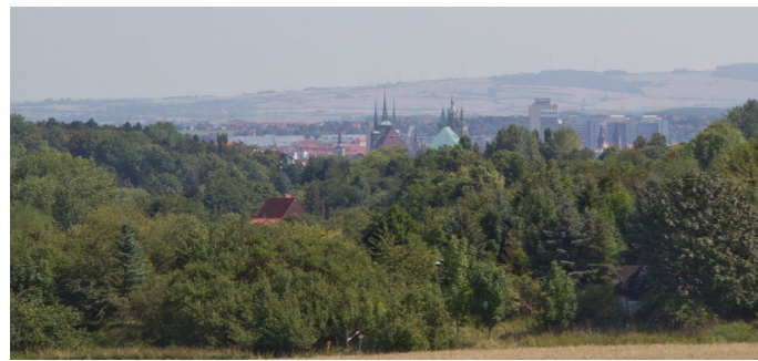
7 Blick über den Grünzug Eselsgraben zum Dom
