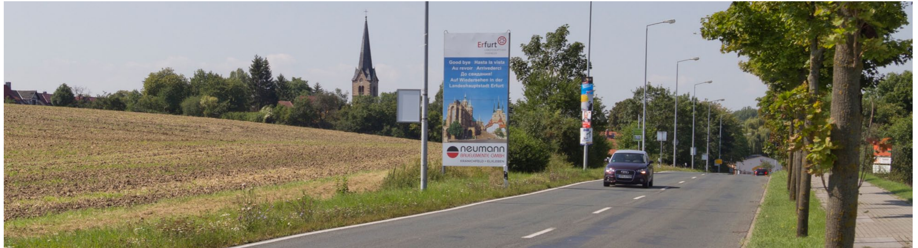
26 Bereich der Hinführung der Stadtbahn an den Rand des alten Ortskernes von Schmira
