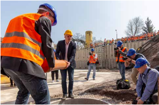
Abb. 20: Grundsteinlegung für das Überlaufbecken in der Karlsstraße 2018
