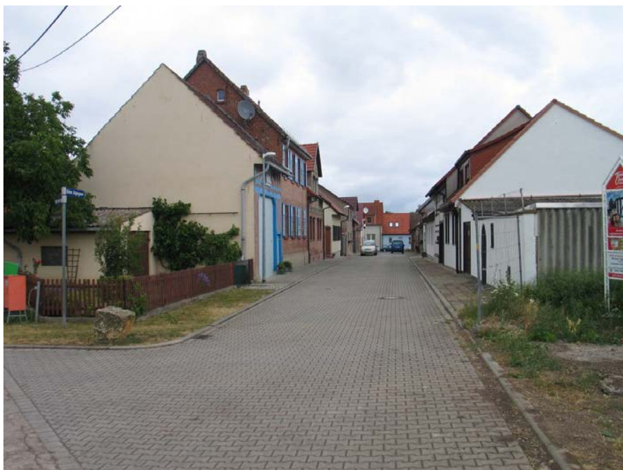
„Kleine Angergasse“ von der Straße „Hinter dem Anger“ aus gesehen (Juni 2018);
