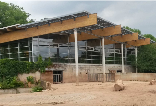
Abbildung 52: Zwei Schiebetore, Vordach mit Lamellen
