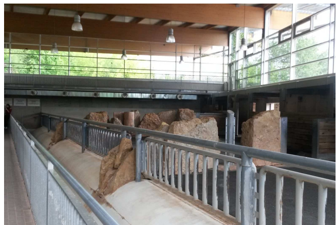
Abbildung 51: Galeriegang an der Ostseite mit Lüftungsrohren
