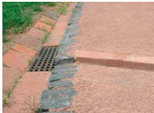
Abbildung 36: Quer- und Längsentwässerung mit Pflastermulden
