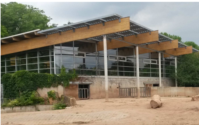
Abbildung 46: Option 1: Nashornhaus für Giraffen adaptieren, neues Nashornhaus auf Erweiterung der Savanne errichten.
