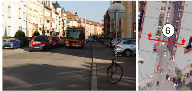
Abb. 36: Straßenabschnitt Albrechtstraße Q 6
