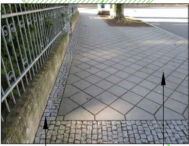
Mosaikpflaster in Reihe senkrecht zur Fahrbahn Platten + Bischofsmützen bis Bord
