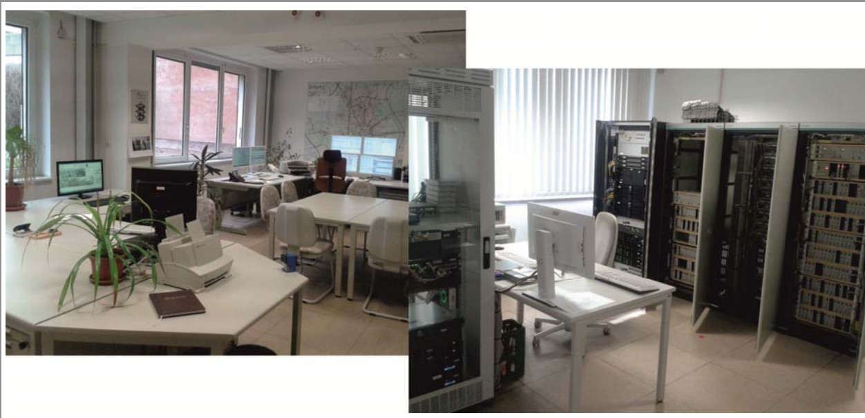
Abbildung 1: Verkehrsleitzentrale (Bedienbereich und Serverbereich)
