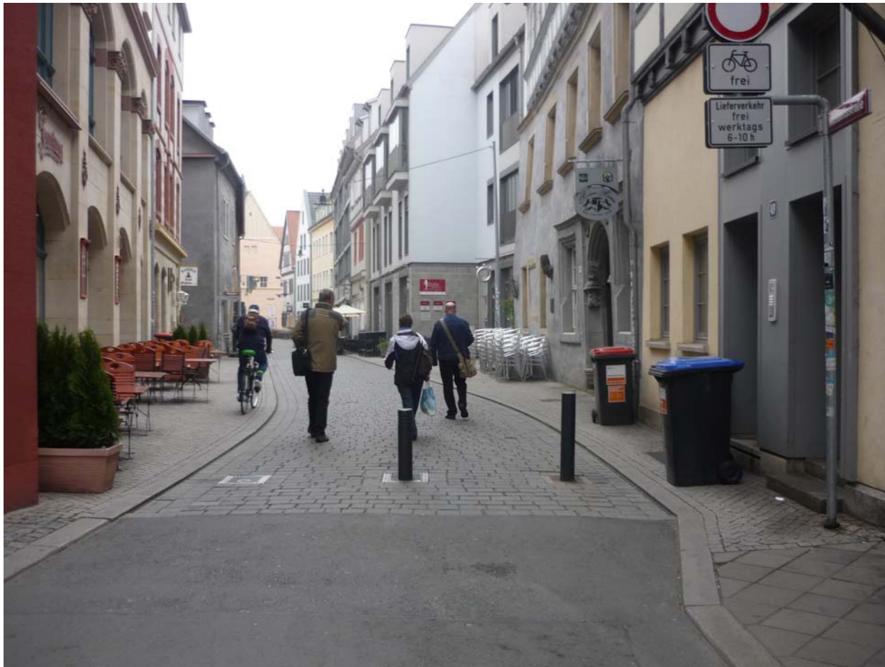
Abbildung 21: Fehlerzustand Polleranlage Michaelisstraße
