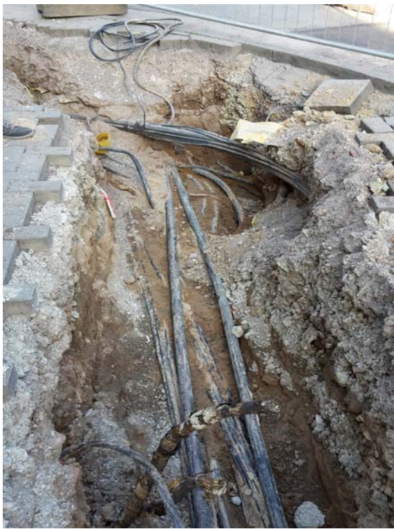
Abbildung 9: Beispiel für Leitungslage im unterirdischen Bauraum
