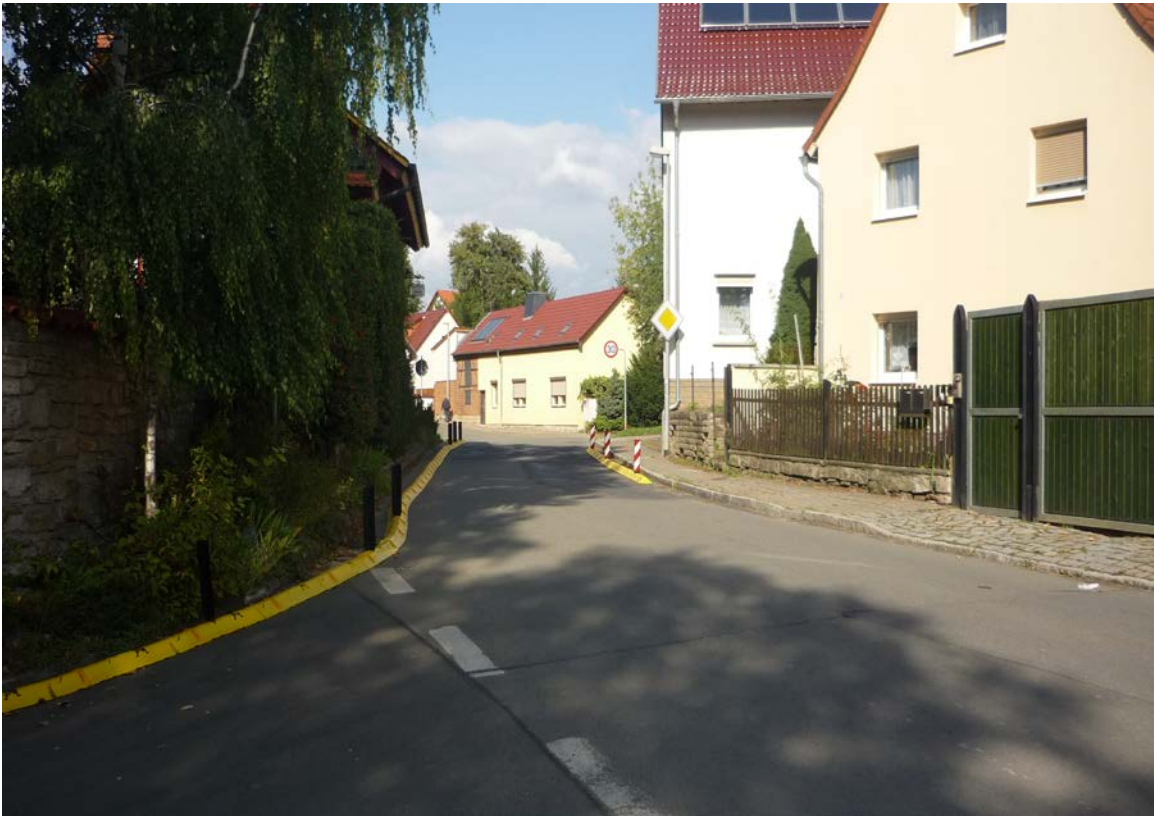
provisorische Einengung, Blick aus Richtung Ortsmitte
