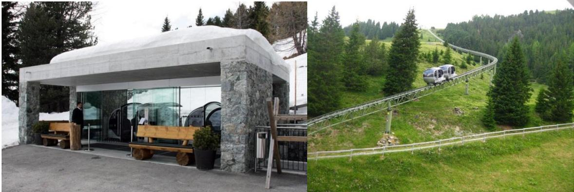
**Abbildung 11: Stationsbauwerk und Strecke einer Mountain Monorail**
