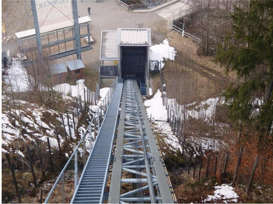
Abbildung 3: Beispiel einer Schienenkonstruktion mit Fluchttreppe „Schrägaufzug Erdinger Arena Oberstdorf“
