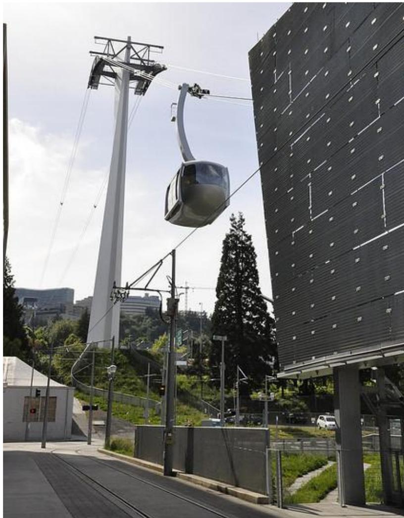
Abbildung 31: Pendelbahn mit Stützenbauwerk
