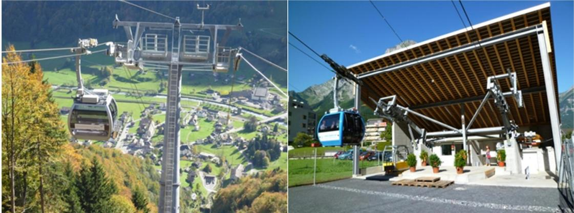
**Abbildung 7: Stütze und Stationsbauwerk einer Kompaktbahn**
