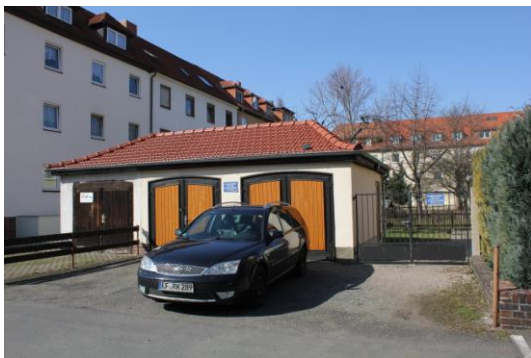
Abb. 63: Wilhelmshavener Straße - sanierte Nebengebäude mit Garagennutzung
