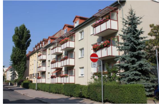
Abb. 52: Hamburger Straße - sanierte Wohngebäude
