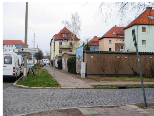
Abb. 34: Garagenanlage Ecke Schlachthof-/ Oldenburger Straße
