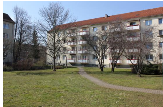
Abb. 54: Emdener Straße - sanierte Wohnanlage
