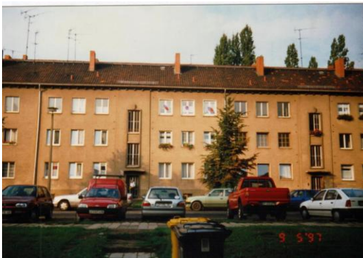
Abb. 7: Wohnhaus Bremer Straße
