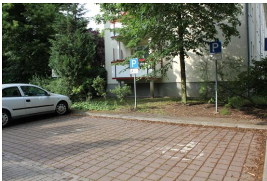
Abb. 134: Emdener Straße - Behindertenstellplätze
