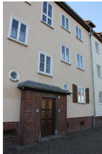
Abb. 56: Greifswalder Straße - saniertes Wohnhaus
