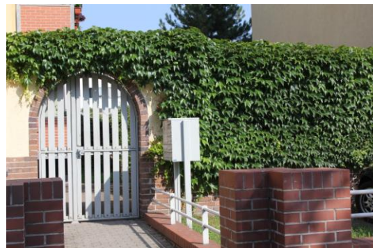
Abb. 88: Hamburger Straße - sanierter Eingangsbereich
