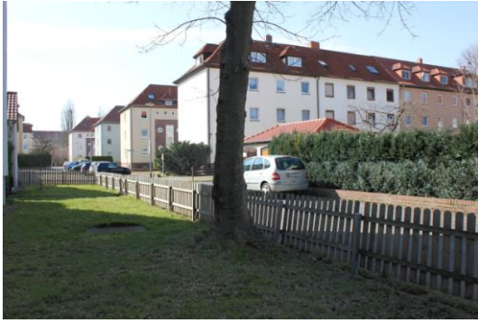
Abb. 51: Wilhelmshavener Straße - sanierte Wohngebäude und Freianlagen
