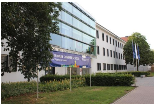
Abb. 65: Altonaer Straße - Fachhochschule (FH) Haupteingang
