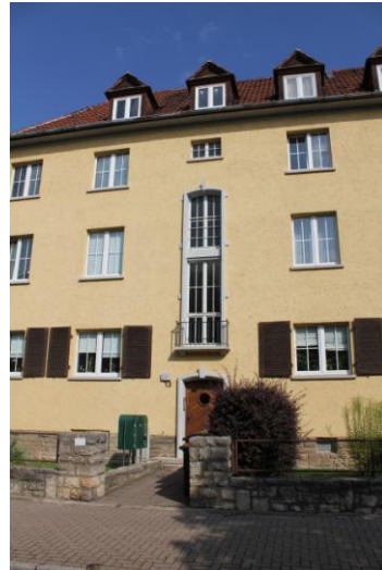
Abb. 58: Hamburger Straße - Sanierung bei Erhalt baulicher Details
