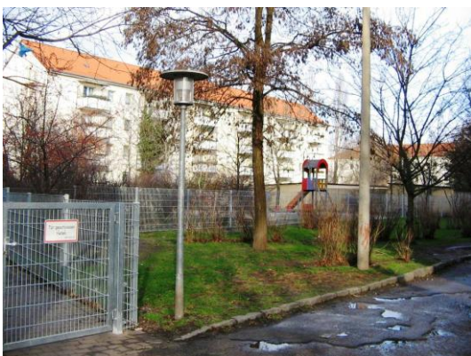
Abb. 21, 22: Innenhof Wohnquartier Emdener-/ Leipziger Straße
