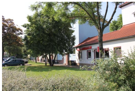
Abb. 64: Greifswalder Straße - sanierte Nebengebäude mit gewerblicher Nutzung
