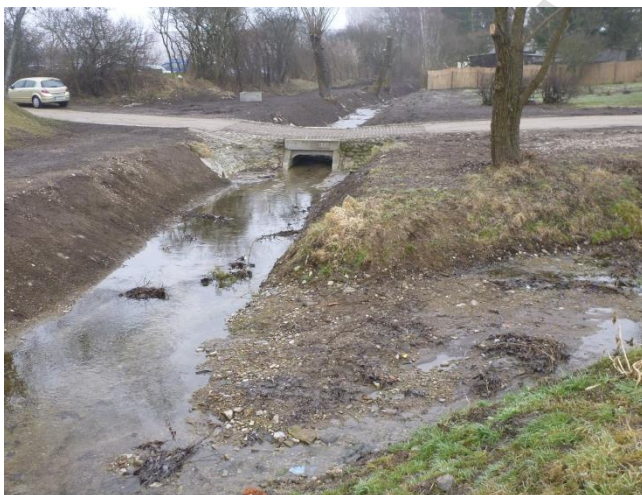
Abbildung 4-8 Peterbach Furtbrücke oberhalb des Zusammenflusses mit dem Urbach (rechts)
