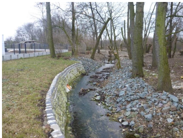
2: Uferbefestigung am Autohaus Gitter in Linderbach
