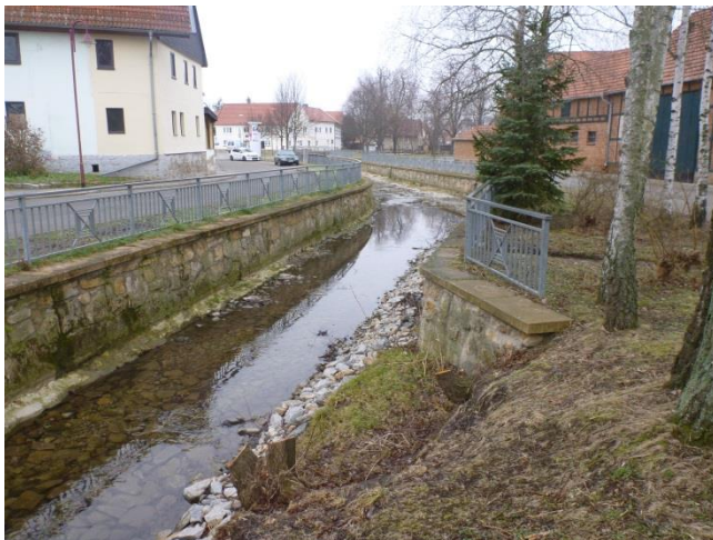
3: Ausgebautes Gerinne in Büßleben
