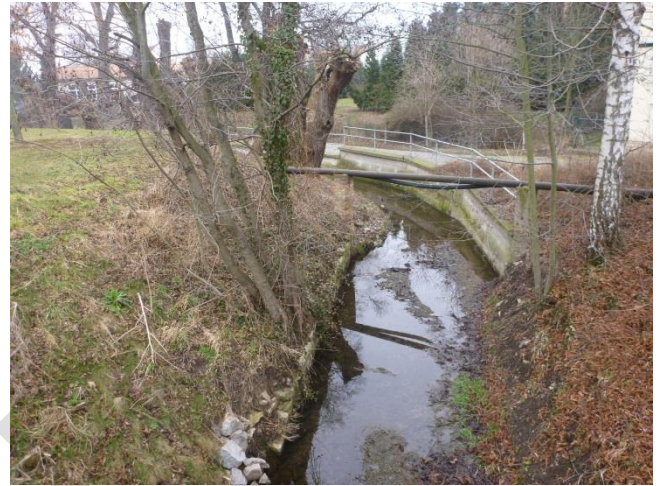
2: Rechte Ufermauer Rudolstädter Straße
