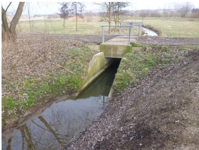
1: Sielbauwerk, Zufluss aus dem GVZ
