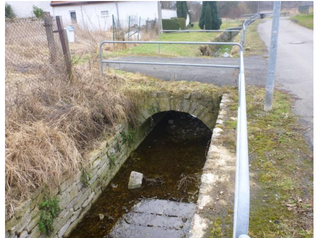
2: Kastengerinne mit Durchlass (bogenförmig)
