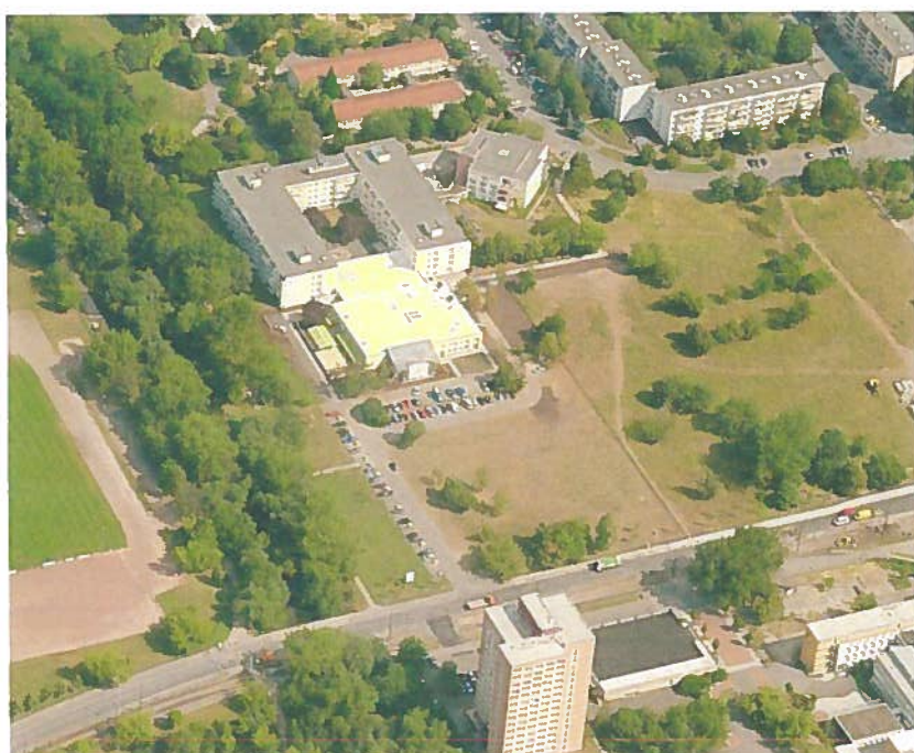
Luftbild des Planungsbereiches aus Süden mit Blickrichtung Norden
