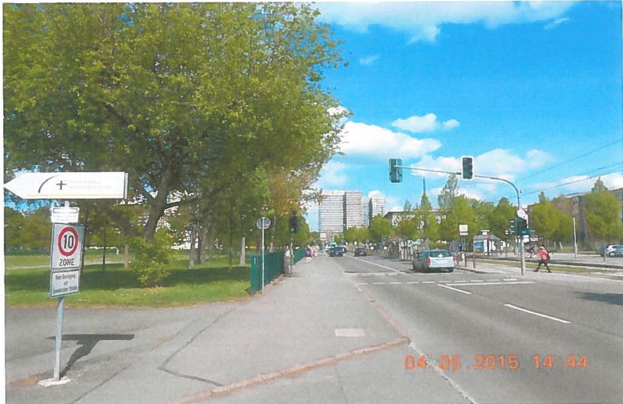
Vorhandene Zufahrt von der Vilniuser Strasse ( Quelle Dr. Walther+Walther ) – Blick nach Osten
