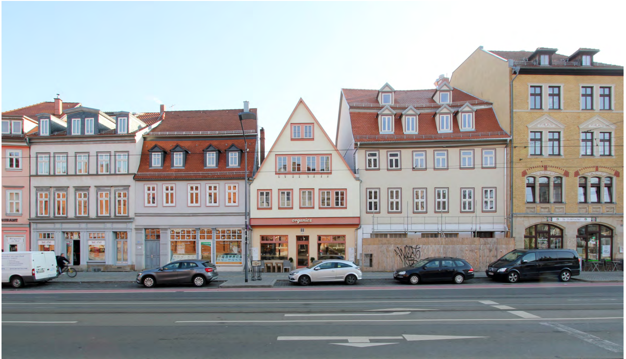
Blockrandabschluss / Ansicht aus der Andreasstraße
