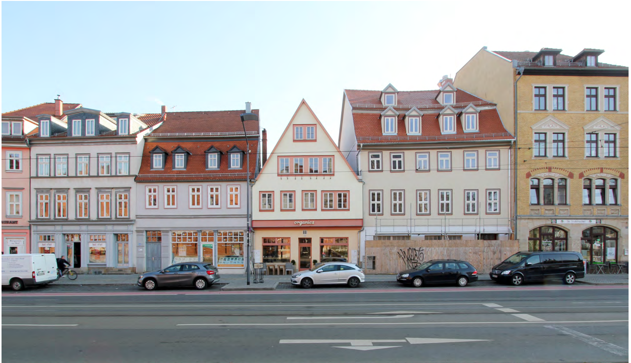
Blockrandabschluss / Ansicht aus der Andreasstraße
