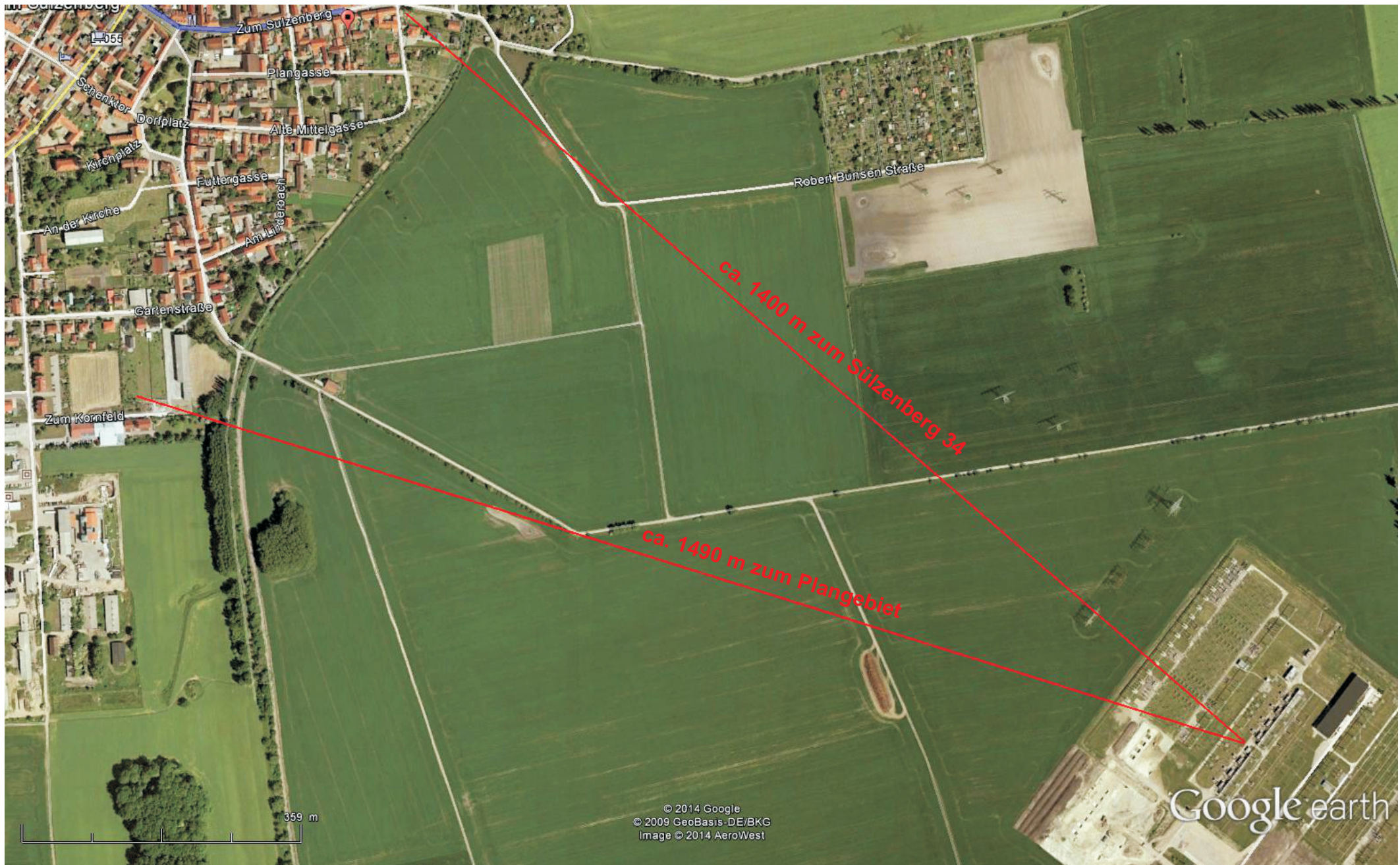
Anlage 11 - LG 85/2014 - Ing.- Büro Frank & Apfel Luftbild mit Lage des Umspannwerkes und mit Abständen zum Sülzenberg 34 (Immissionspunkt aus Prognose Umspannwerk) und zum Plangebiet, M ca. 1 : 6200
