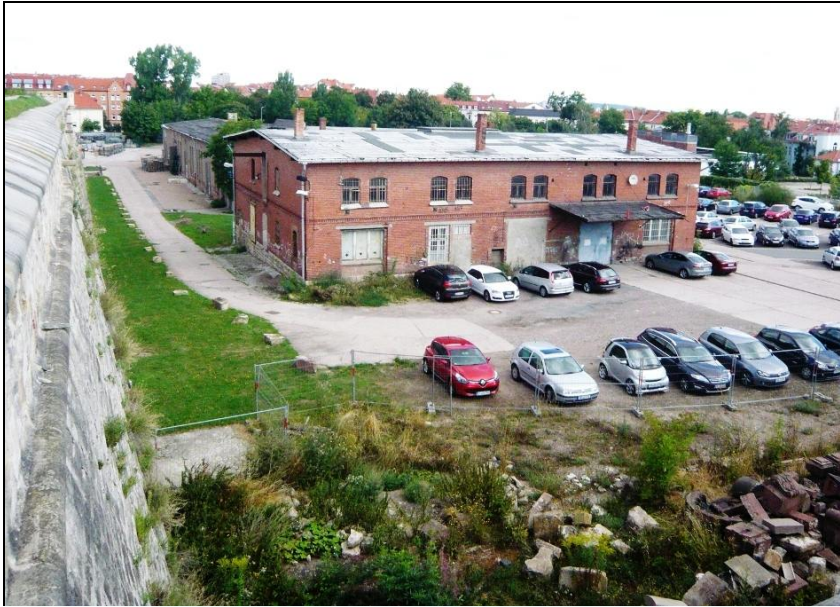
Die Fläche vom mittleren Plateau des Petersberges aus betrachtet, dominierend sind die Stellplätze sowie der hohe Versiegelungsgrad der Fläche
