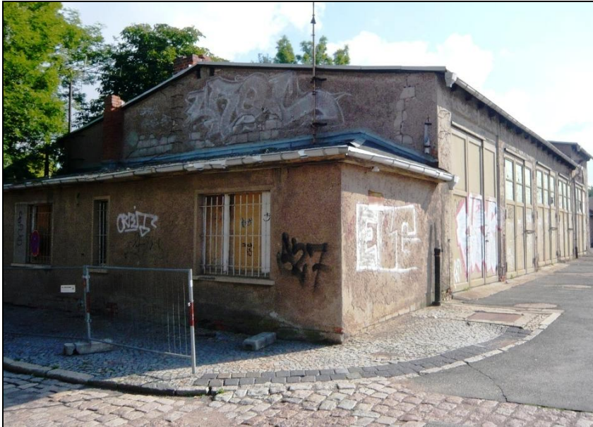
ehemalige LKW- Garagen an der Zufahrt von der Blumenstraße
