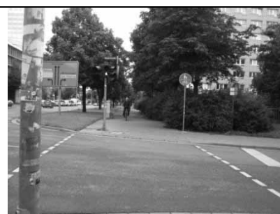
Juri-Gagarin-Ring / Meyfartstraße: Führung im Seitenraum auf bestehendem Weg Borde an Querungen besser absenken Geh- und Radweg durch Markierung oder unterschiedliche Materialwahl trennen; Radweg für Zweirichtungsverkehr vorsehen (mind. 2 m breit) ggf. Verbreiterung in Grünfläche
