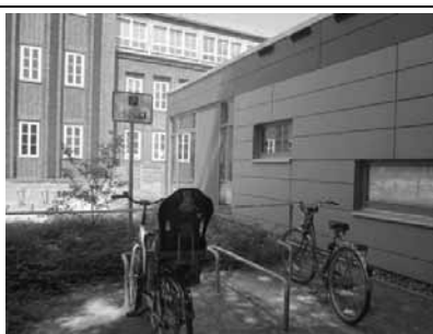
Fahrradabstellanlage Kita (Braunschweig)
