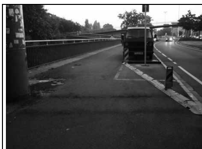
Westliche Tunnelröhre: Seitenraum verbreitern und als getrennten Geh- und Radweg für Zweirichtungsradverkehr ausweisen
