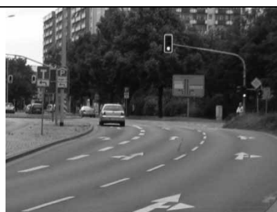
Juri-Gagarin-Ring / Meyfartstraße: Direktes Linksabbiegen vom Juri-Gagarin-Ring in Richtung Innenstadt. ermöglichen Radfahrstreifen frühzeitig „öffnen“ und Schutzstreifen in Kfz-Linksabbiegestreifen markieren
