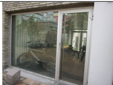
Fahrradabstellanlage im Wohneingangsbereich (Malmö)
