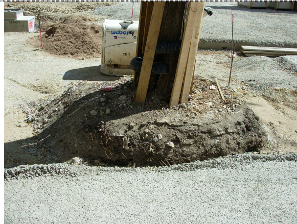
Abb. 3: Baumumfeld während Baumaßnahme (Quelle: Gartenamt Erfurt)
