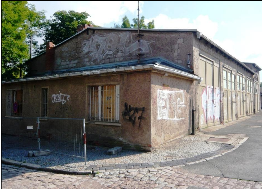
ehemalige LKW- Garagen an der Zufahrt von der Blumenstraße
