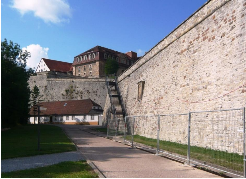
die angrenzenden Festungsmauern des Petersberges definieren die maximale Höhe der zukünftigen Neubebauung
