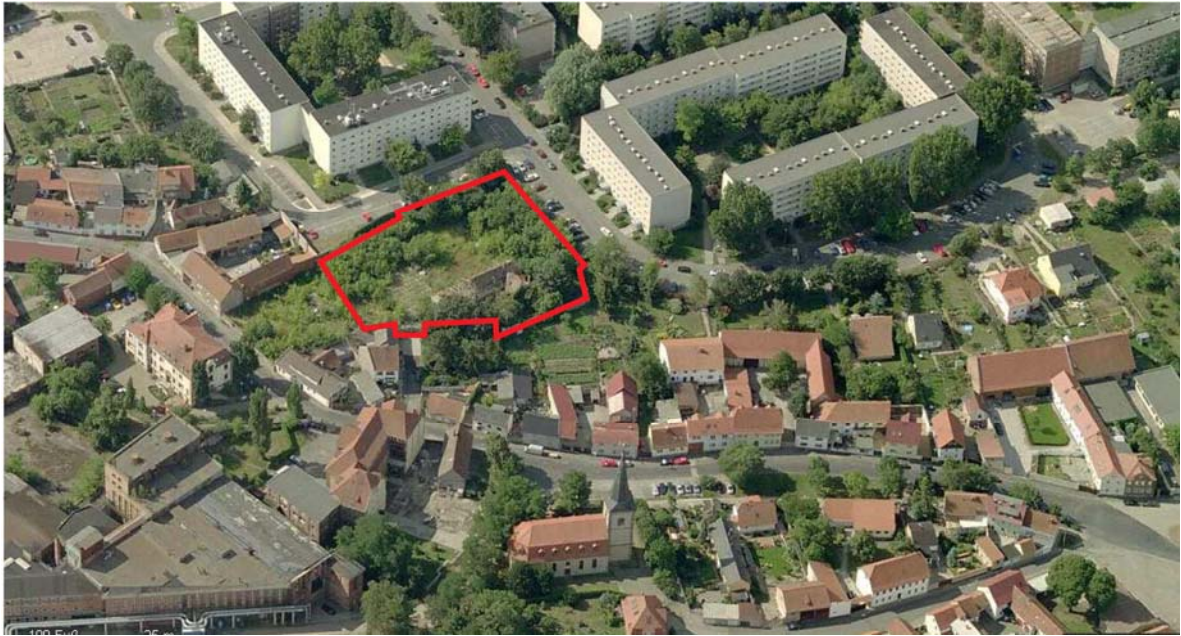
Fläche für die geplante Wohnanlage am Kilianipark in Erfurt-Gispersleben (aus bing.com – 2008)
