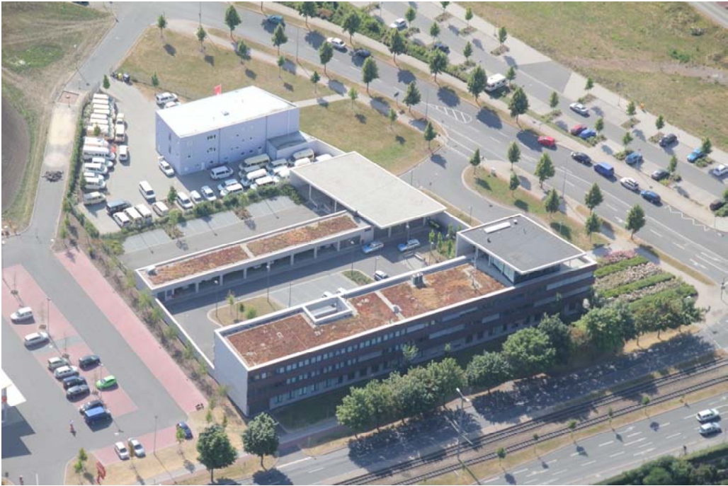
Neubau Polizeiinspektion Nord
