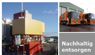
Foto: SWE Stadtwerke Erfurt GmbH
