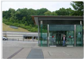
Foto: SWE Stadtwerke Erfurt GmbH
