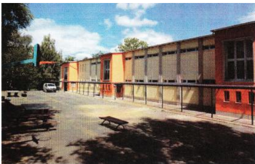
Nordfassade mit Wärmedämmverbundsystem nach Abschluss der Arbeiten
