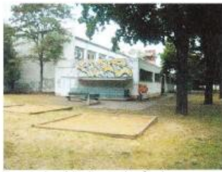
Bestandsgebäude vor der Sanierung
