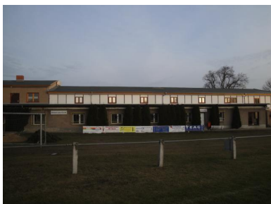
Bild links: Turnhalle Töttelstädt, Erneueres Dach + neue Fenster
