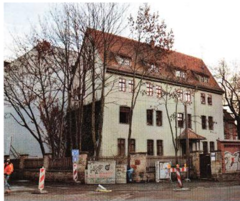
Ansicht Süd/Ost nach der Sanierung
