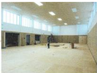
Montage Sportboden, Prallschutz, Tore
