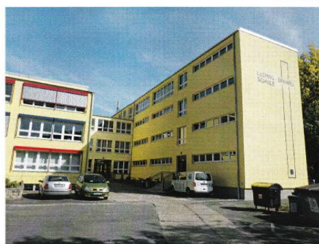
Fassade nach Sanierung, Südflügel/Nordseite, Verbinder Teil des Mitteltraktes/Westseite
