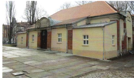
Ost- Nordansicht nach der Sanierung
