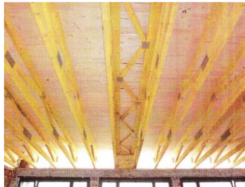
neue Dachbinder mit Windverband
