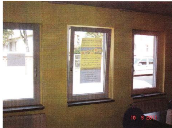
Fenster Strassenseite innen nachher, incl. Farbanpassung
