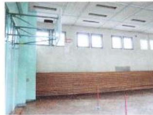
Sporthalle vor der Sanierung
