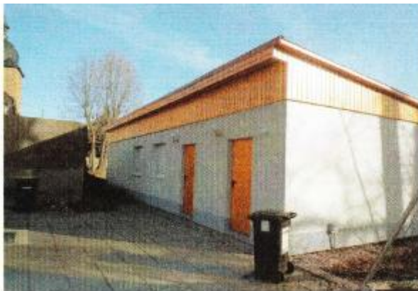
Fertiggestellte Fassade (Vorder- und Rückseite)
