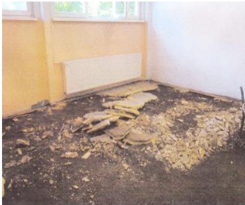
Bild 2 Abbruch Bestandsfußboden bis auf OK Bodenplatte
