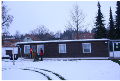
Bild links: Sportstätte Möbiusburg, neue Dacheindeckung
