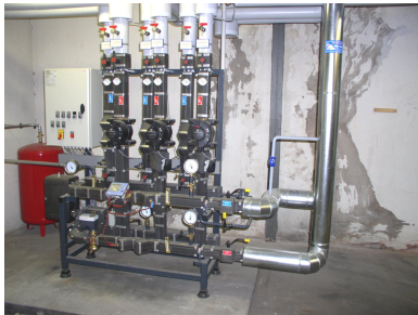
Bild links: Judohalle Wiesenhügel, neue Hausanschlussstation
