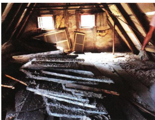
Dachboden beim Abbruch der maroden Deckenschalung und Altdämmung
