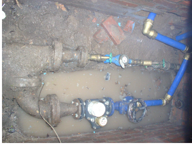
Bild links: Sportstätte W.-Busch-Straße, neue Wasserleitung + Anschluss
