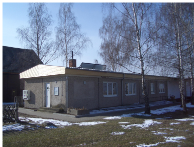
Bild links: Sportplatzanlage Schwerborn, neue Dacheindeckung
