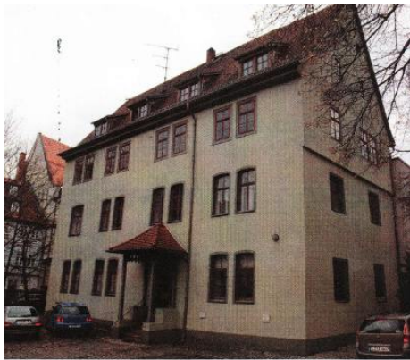
Das Gebäude vor der Sanierung – Ansicht Nord vom Hof
