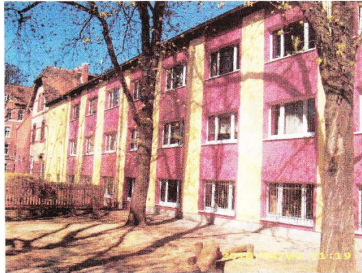
06.04.2011: Fertigstellung der Fassadenarbeiten
