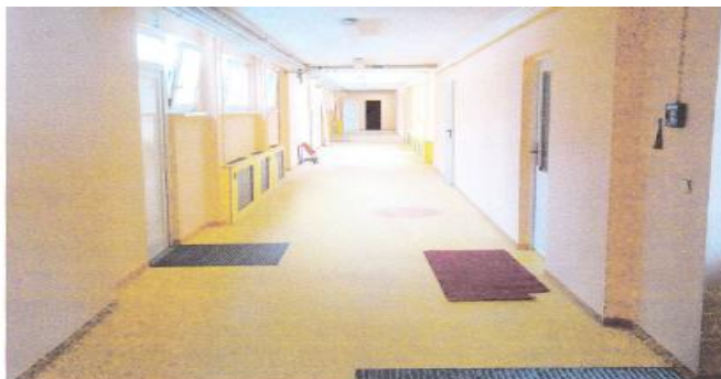
Bild 7 Ansicht Flur nach der Sanierung
