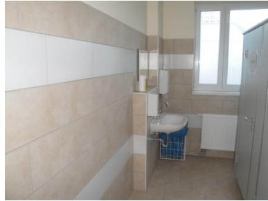
Bild rechts: neuer Sanitärbereich
