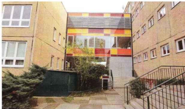
Fassade nach der energetischen Sanierung, einschließlich Eingangsbereich - Gymnasium "Heinrich-Hertz", Erfurt.
