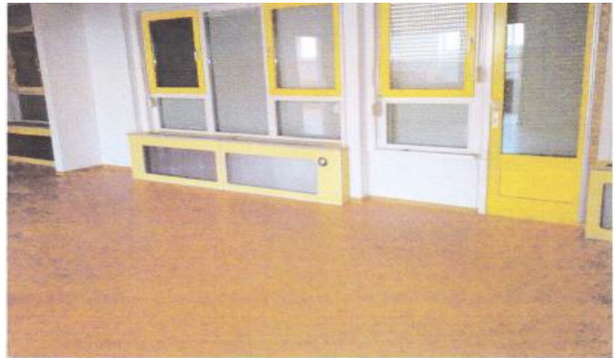
Bild 3 Gruppenraum nach der Sanierung
