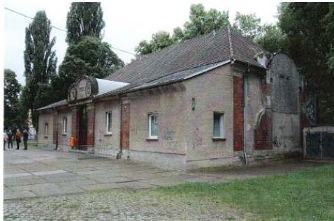
Ost- Nordansicht vor der Sanierung
