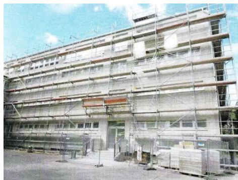
Fassadendämmarbeiten, Bauzustand
