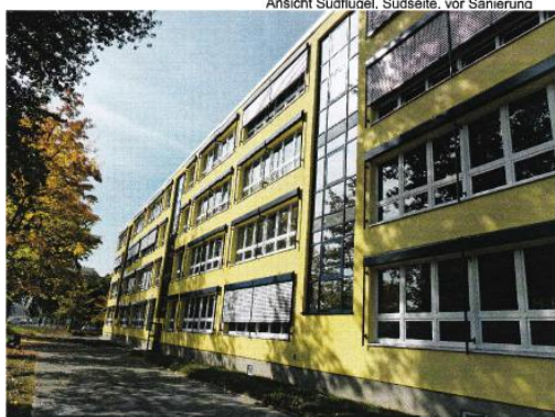
Fassade nach Sanierung, Südflügel/Südseite mit Sonnenschutzanlagen und neuer Treppenhausverglasung
