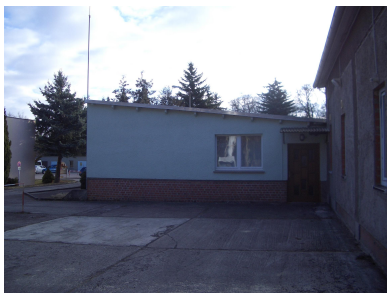
Bild links: Schießsportanlage Steigerwald, Erneuerung Teilflächen Dach
