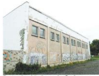
Bestandsgebäude vor der Sanierung
