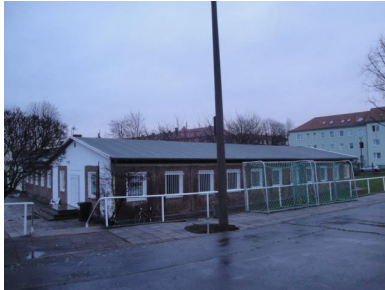
Bild links: Borntal Dachsanierung
