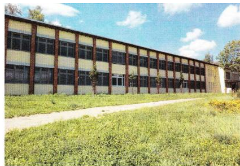
Südfassade nach Osten mit WDVS u. Sonnenschutz nach Abschluss der Arbeiten
