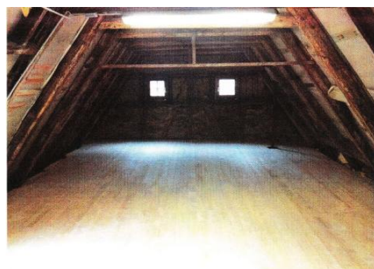
Dachboden mit neuer Deckenschalung
