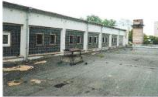
Dach Sporthalle vor der Sanierung
