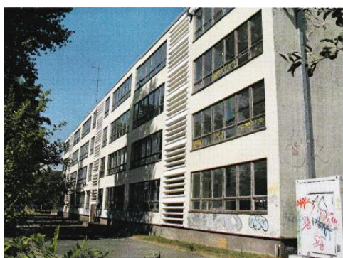
Ansicht Südflügel, Südseite, vor Sanierung
