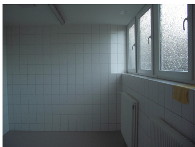
Bild links: Essener Str.16, Modernisierter Sanitärbereich
