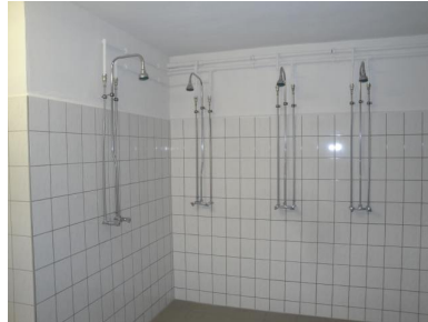
Bild rechts: sanierter Duschbereich
