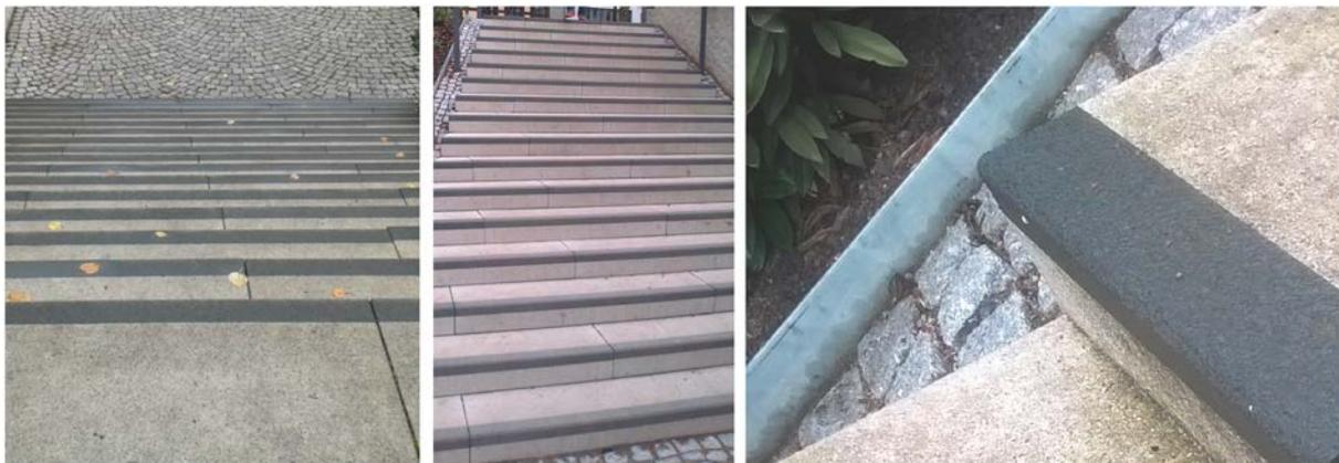
**Abbildung 6: Stufenkantenmarkierung an Treppenanlage Mikwe**
