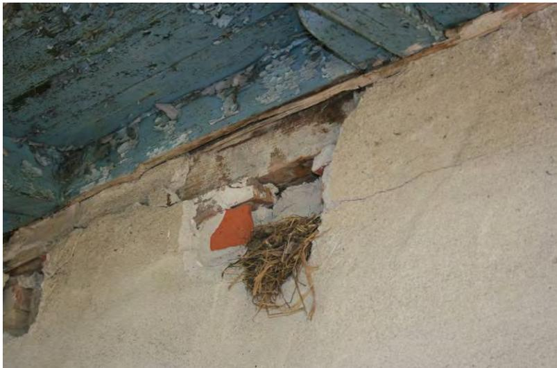
**Abb. 9: Spalten an Fassade
