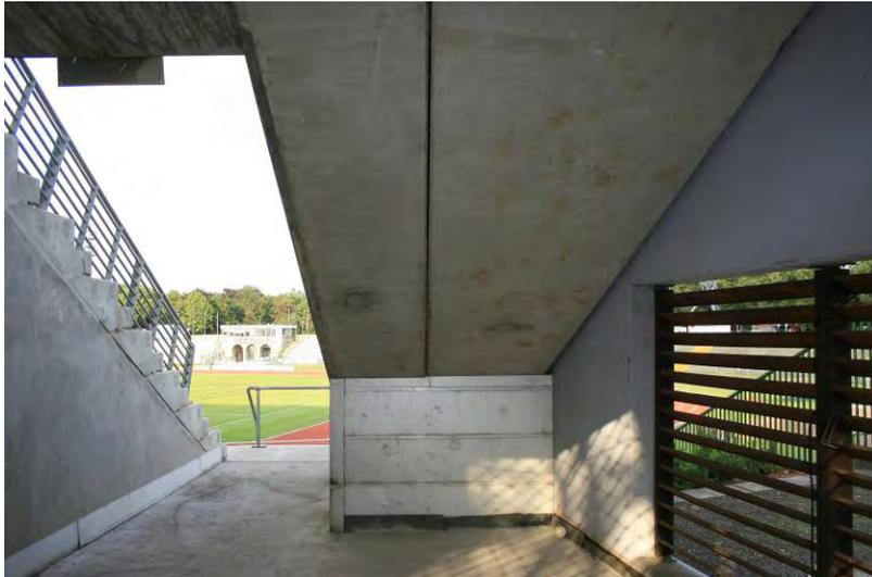
**Abb. 5: Deckenspalten im Zugang Block A**
