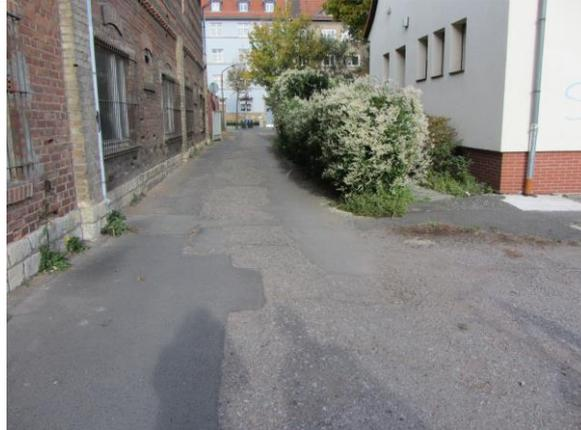
Aufgrund unterschiedlicher Fundamentreste sind noch größere Absätze und Höhenunterschiede auf der Fläche vorhanden. Außerdem existieren zahlreiche Einbrüche und Löcher. Eine öffentliche Nutzung bedarf zuvor umfangreicher Baumaßnahmen (vollständige Entfernung der Fundamentreste und Erdauffüllungen).
